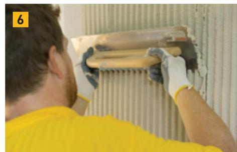
6 Applicare uno strato di rasatura con Malta Leggera Multipor con spatola a denti quadrati da 10 mm.
