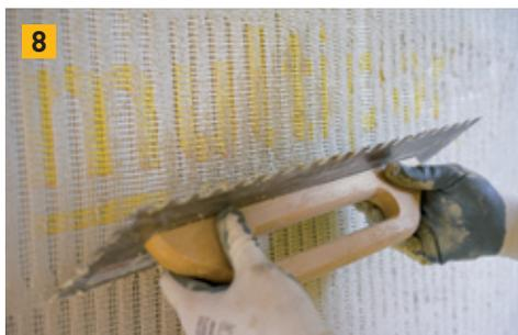
8 Passare un secondo strato di rasatura con Malta Leggera Multipor o livellare (lo spessore totale deve essere di 5 mm).
