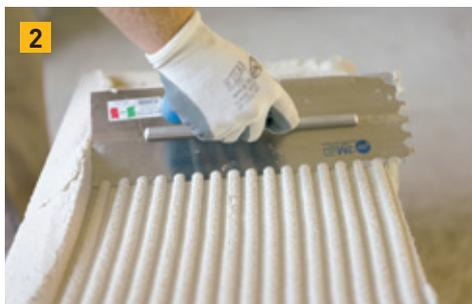
2 Miscelare 20 kg di Malta Leggera Multipor con 8 l di acqua pulita e stendere la malta sul 100% della superficie dei pannelli con spatola dentata da 10 mm.
